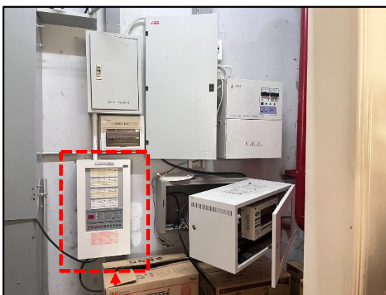
ตู้ควบคุมระบบสัญญาณแจ้งเหตุเพลิงไหม้
